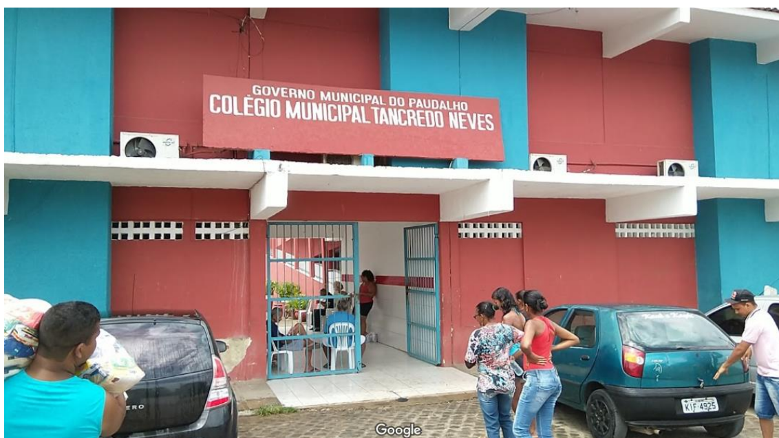
Imagem 1: entrada do Colégio Municipal Tancredo Neves
